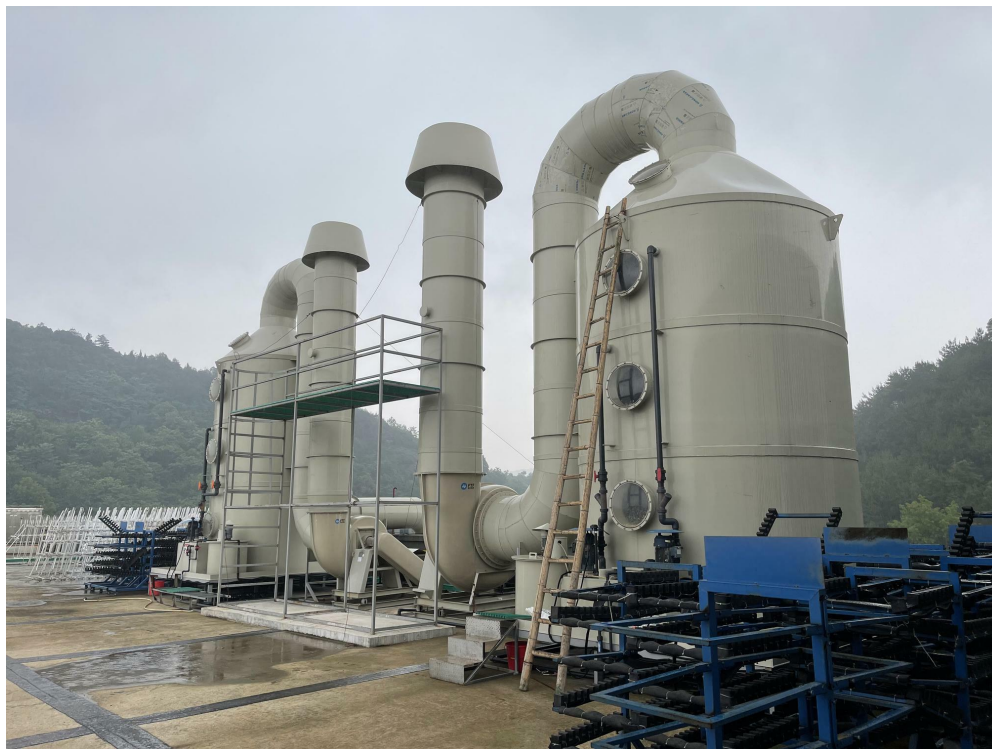
图 4-8 氧化废气处理设施图
