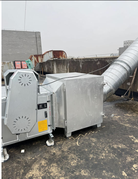
图 3-3 废气处理设施图
