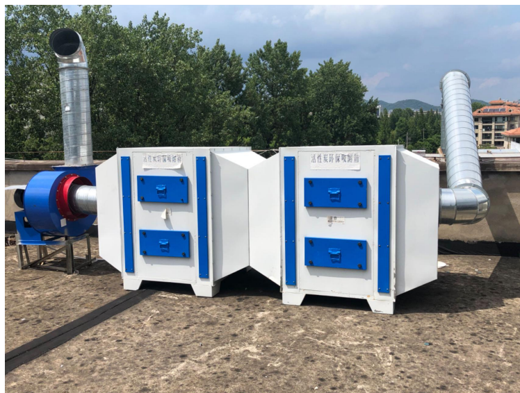
图 3-2 注塑废气、硫化成型废气处理设施图
